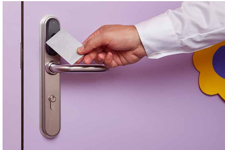
Im Gefahrenfall von außen: Zutritt nur per Sonderberechtigung
